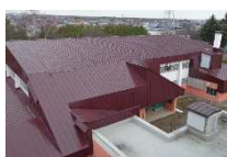
【屋根の全面張替え】
